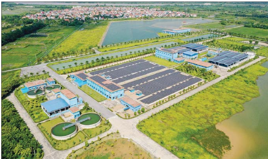
베트남 하노이에 위치한 송동정수장 전경. 하루 30만m 3 의 수돗물 생산능력을 갖추고 약 300만 명의 하노이 동부지역 주민에게 깨끗한 물을 공급하는 주요 시설로, 한국수자원공사의 AI 기술을 도입해 약품주입 자동제어와 운영 효율화를 추진할 예정이다. /한국수자원공사
