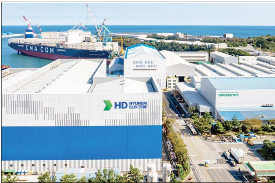
HD현대일렉트릭 울산 사업장 전경.
