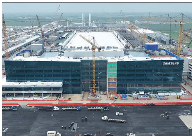
미국 텍사스주 테일러시에 건설 중인 삼성전자 반도체 공장. /삼성전자
