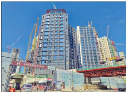
서울 서초구 반포동 반포주공 1단지 1·2·4주구 재건축 ‘디에이치 반포124’ 공사현장. /안상미 기자
