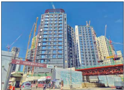
서울 서초구 반포동 반포주공 1단지 1·2·4주구 재건축 ‘디에이치 반포124’ 공사현장.
