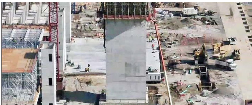
삼성전자가 미국 텍사스주 테일러시에 건설하고 있는 반도체 공장(위)과 SK하이닉스의 미국 인디애나주에서 인공지능(AI) 메모리용 어드밴스드 패키징 생산기지 건설 모습. /각사
