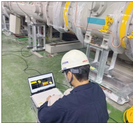
과학화 장비(부분방전 진단장비)를 이용해 가스절연 개폐장치를 진단하는 모습. /한전
