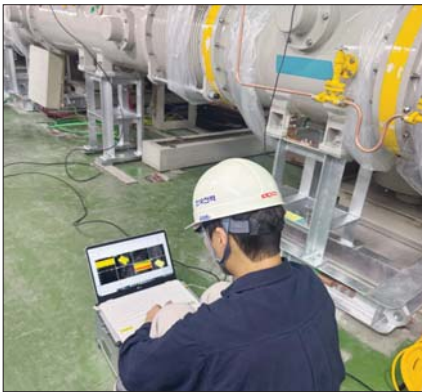
과학화 장비(부분방전 진단장비)를 이용해 가스절연 개폐장치를 진단하는 모습. /한전
