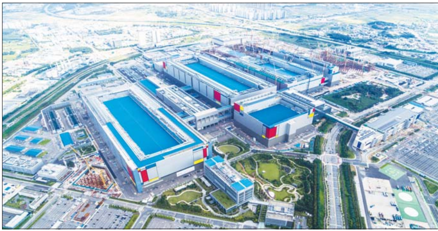
삼성전자 평택캠퍼스 전경.
