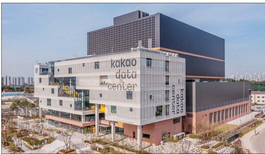
카카오 데이터센터 안산 전경
