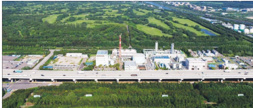
인천 서구 수도권매립지 내 50메가와트 매립가스 발전시설.
