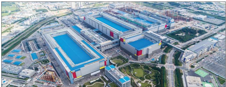
삼성전자 평택캠퍼스 전경.
