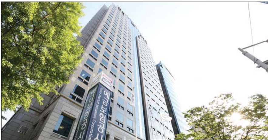
서울 중구 예금보험공사 전경.
