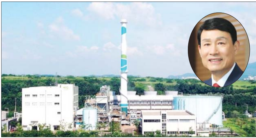
수도권매립지관리공사 50MW 규모 매립가스 발전시설. (원형사진) 송병역 사장
