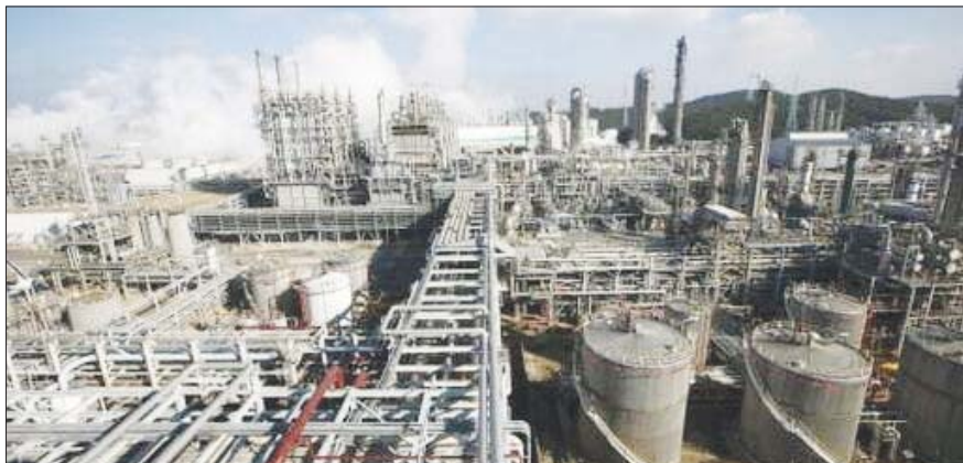
롯데케미칼 대산공장 전경.
