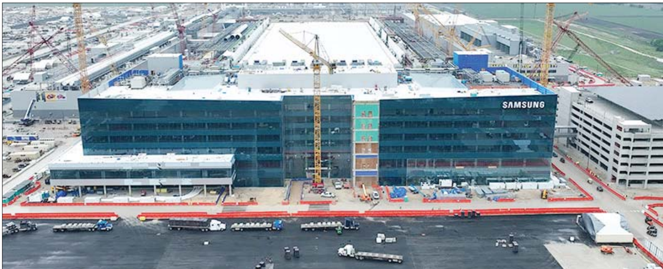
삼성전자가 미국 텍사스주 테일러시에 건설하고 있는 반도체 공장.
