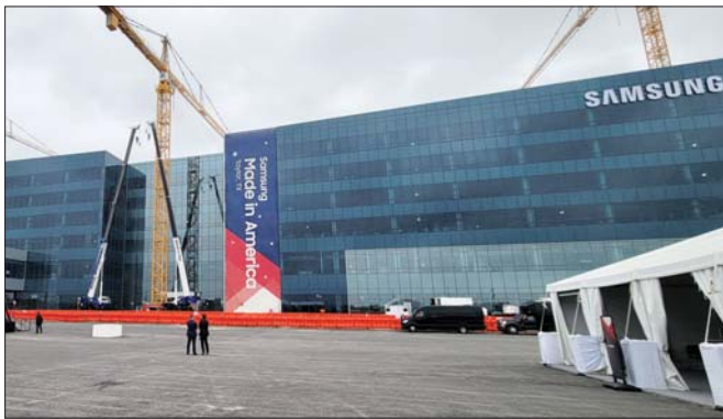
삼성전자 미국 텍사스주 테일러시반도체 공장.
