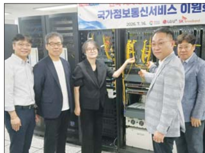
경남도가 국가정보통신망 백본전송망과 도 행정통신망의 지역 이원화 구축을 완료했다. /경남도
