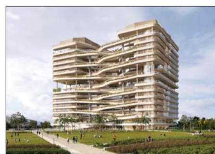
청라 그룹헤드쿼터(HQ). /하나금융그룹
