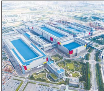
삼성전자 평택캠퍼스 전경.
