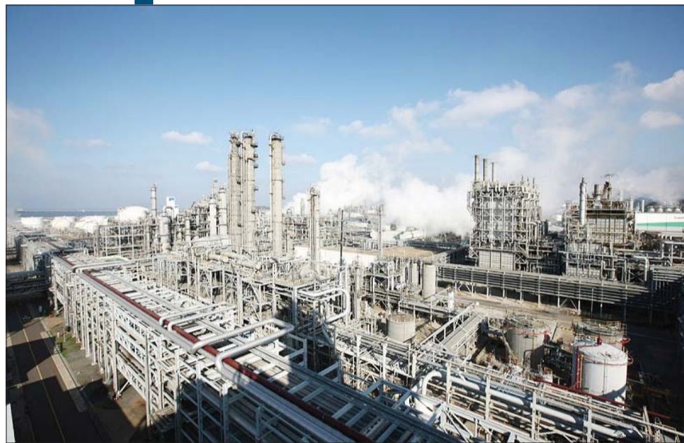
롯데케미칼 대산공장 전경.
