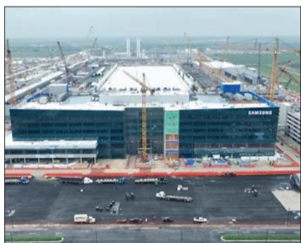
미국 텍사스주 테일러시에 건설 중인 삼성전자 반도체 공장 전경. /삼성전자
