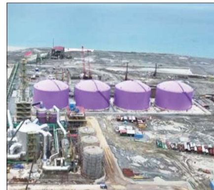
현재 건설 중인 인도네시아 솔라웨시 BNSI 제련소 현장 전경. /에코프로 그룹
