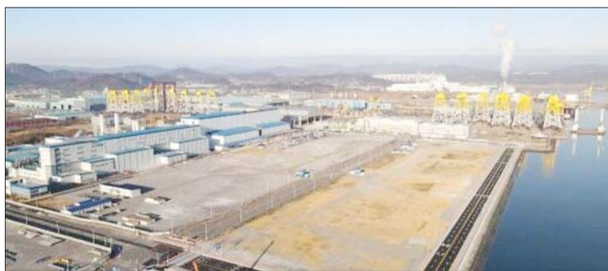
국내 첫 리튬 정광·수산화리튬 가공 사업을 진행하는 포스코필바리튬솔루션 광양 공장 모습. /포스코
