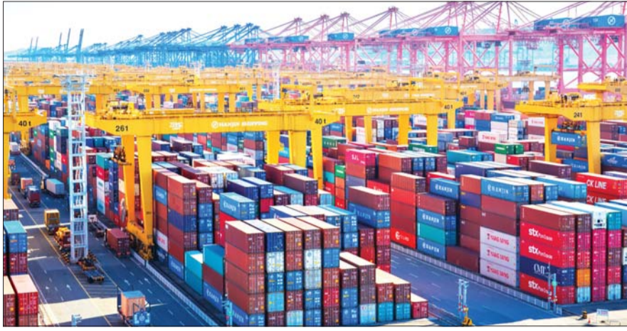
와이어로프 진단장비 부착 대상물인 부산항 내 항만크레인장비들.
