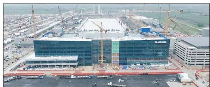
미국 텍사스주 테일러시에 건설 중인 삼성전자 반도체 공장 전경. /삼성전자
