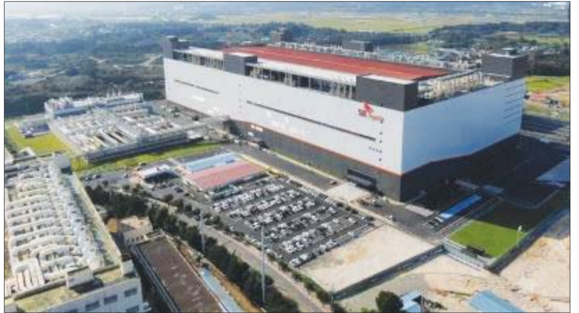
/SK하이닉스 SK하이닉스 청주캠퍼스 전경.
