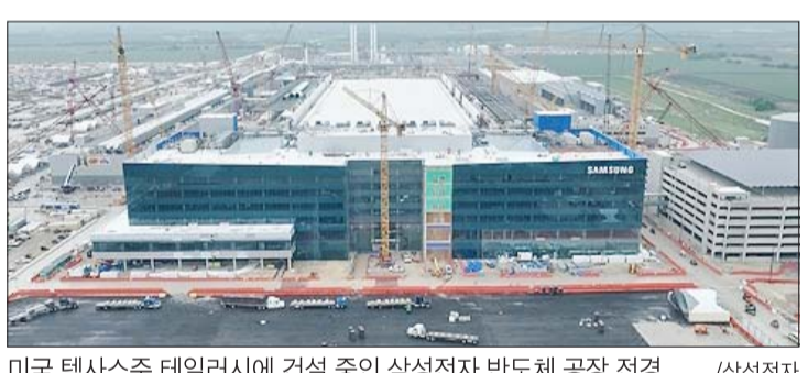
미국 텍사스주 테일러시에 건설 중인 삼성전자 반도체 공장 전경. /삼성전자
