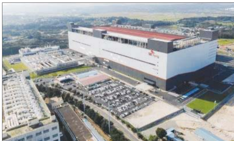
SK하이닉스 청주캠퍼스 전경.
