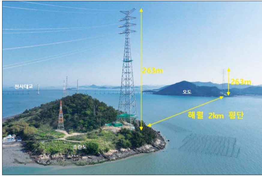
154kV 무안-신안 간 송전선로 사업. /한전
