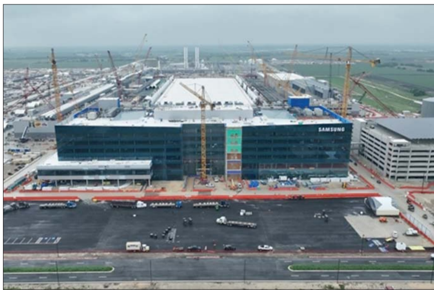
미국 텍사스주 테일러시에 건설 중인 삼성전자 반도체 공장 전경.
