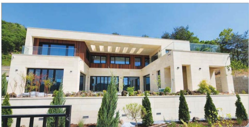
유성훈 대표가 직접 홈 네트워크 시공에 참여한 강원도 홍천 소재의 프리미엄 단독주택.
