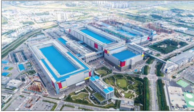
삼성전자 평택캠퍼스 전경.
