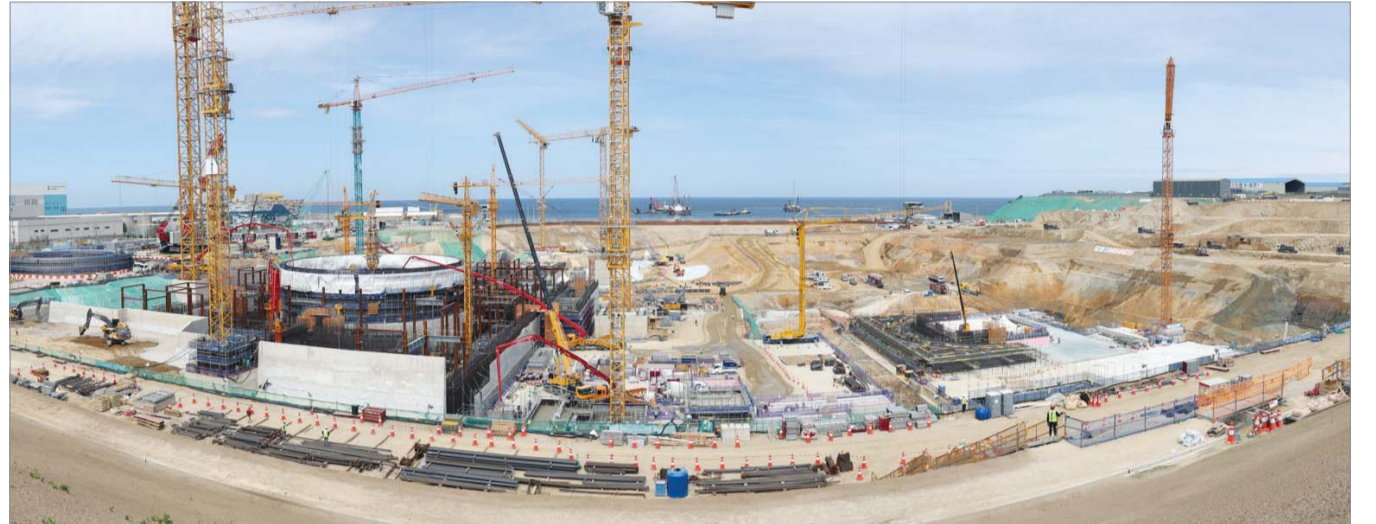
신한울 3·4호기 건설현장.
