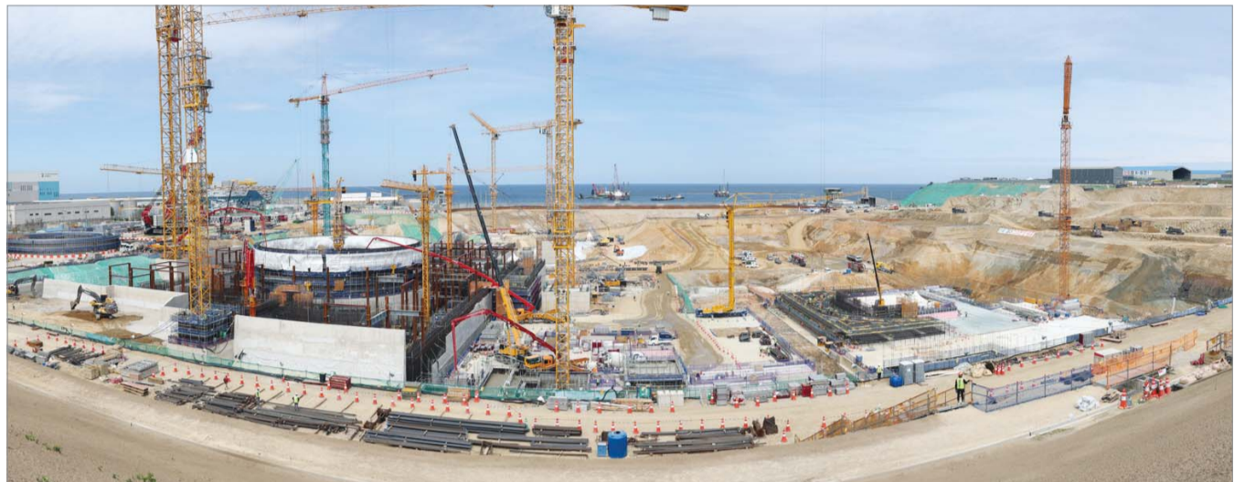
신한울 3·4호기 건설현장.
