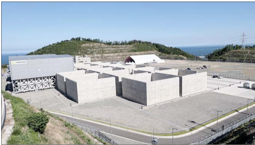
경주시 문무대왕면 중저준위 방사성폐기물 처분시설 내 2단계 표층처분시설 전경.
