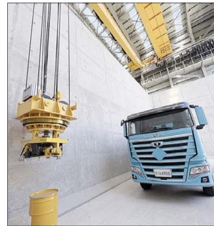
경주시 문무대왕면 중저준위 방사성폐기물 처분시설 내 2단계 표층처분시설. /세종=한용수 기자
