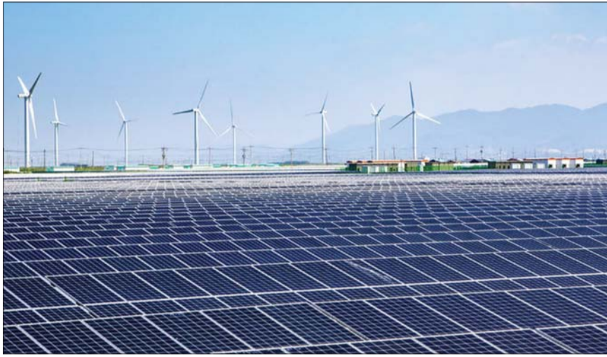
전남 영광에 조성된 태양광·풍력 재생에너지 발전단지. /뉴시스
