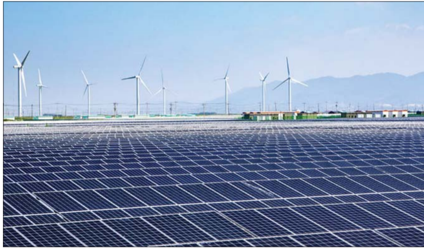
전남 영광에 조성된 태양광·풍력 재생에너지 발전단지. /뉴시스
