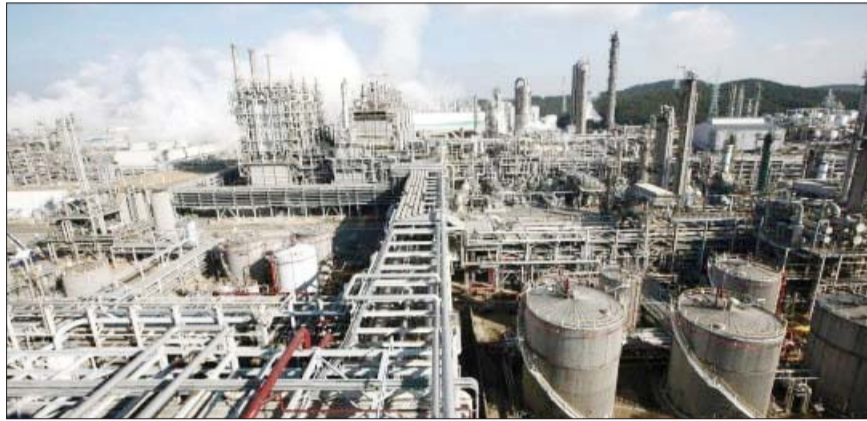
롯데케미칼 대산공장 전경.
