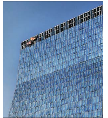
SK텔레콤 을지로 사옥. /SK텔레콤
