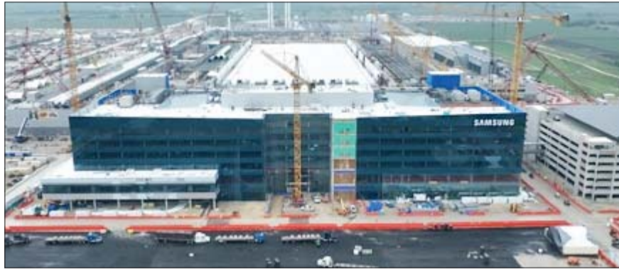
미국 텍사스주 테일러시에 건설 중인 삼성전자 반도체 공장 전경. /삼성전자
