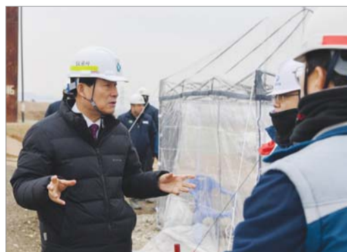
매립시설 현장 점검에 나선 송병역 사장.
