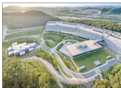
네이버 데이터센터 각세종 전경.
