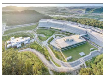
네이버 데이터센터 각세종 전경. /네이버
