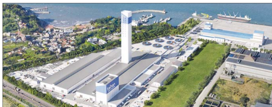
대한전선 당진해저케이블 2공장 조감도. /대한전선
