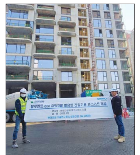
삼표그룹은 현대건설과 0°C에서도 굳는 간절기 특수 콘크리트를 개발해 현장에 적용했다.
