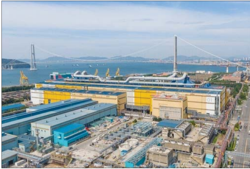
광양제철소 하이퍼 NO 공장 건설 현장 모습.
