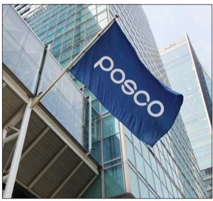
포스코센터 전경. /포스코
