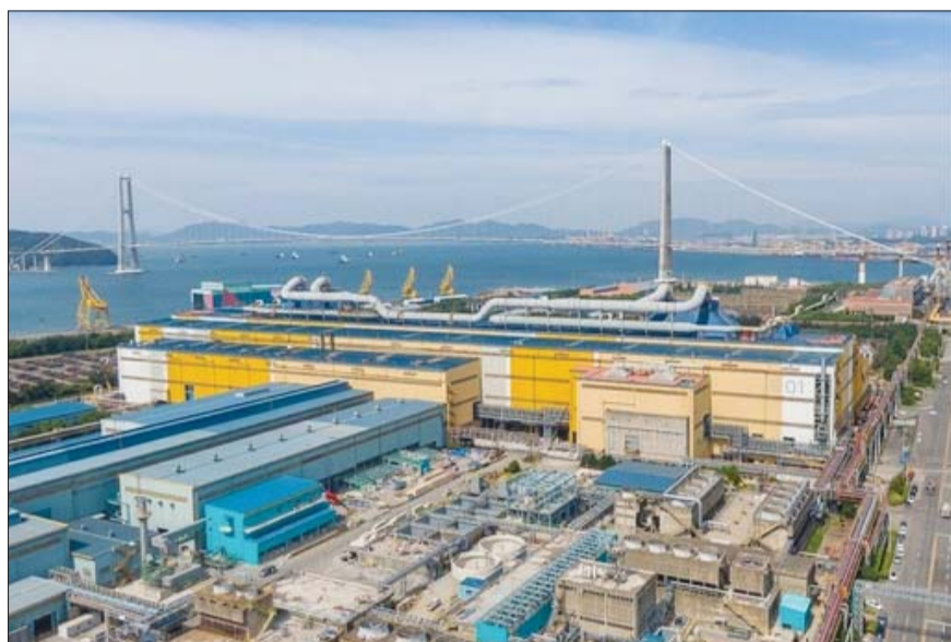
광양제철소 하이퍼 NO 공장 건설 현장 모습.
