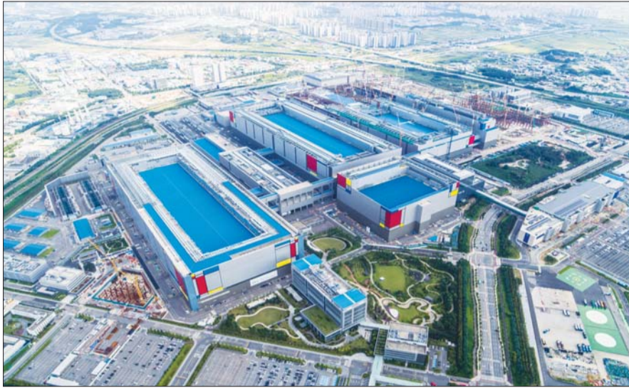
삼성전자 평택캠퍼스 전경.
