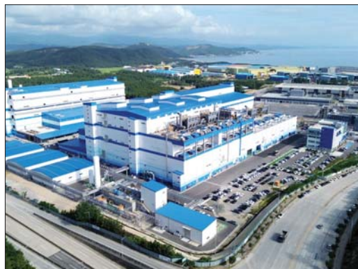
포스코퓨처엠 포항 양극재 공장 전경. /포스코퓨처엠
