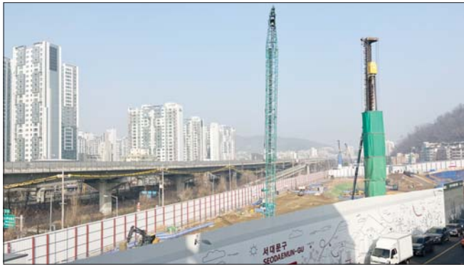
'드파인 연희' 공사 현장.
