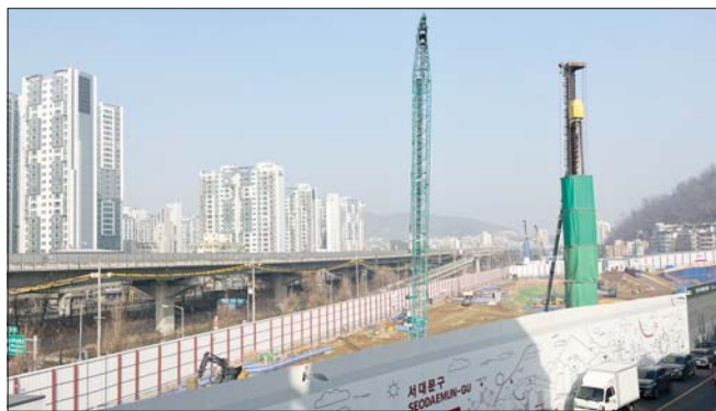
‘드파인 연희’ 공사 현장.
